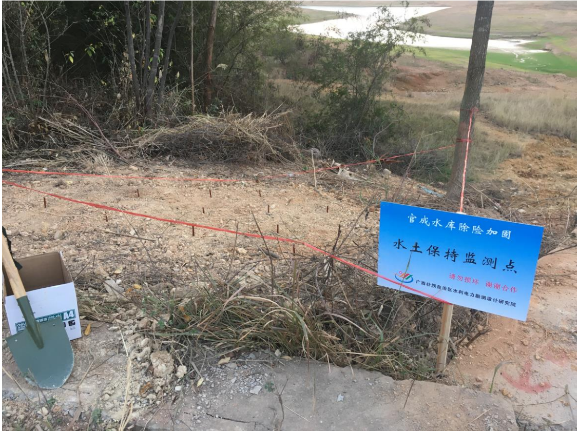
图 1-4-2 九副坝边坡监测点
